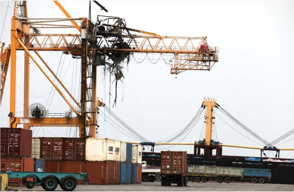
ترميم مٌجل تحت القصف
